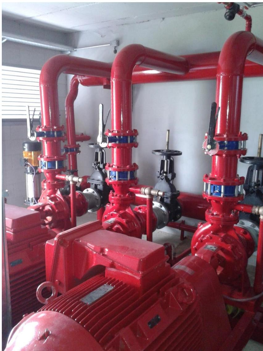
Las válvulas de alivio o de recirculación, se observan en las tres electrobombas, a la salida de las mismas y antes de la válvula de retención.
