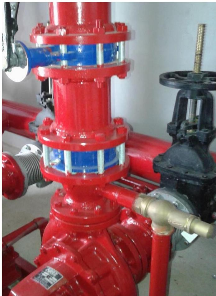
Detalle de una válvula de alivio o de recirculación. El cano desemboca en un desagüe y la salida de agua es visible.
