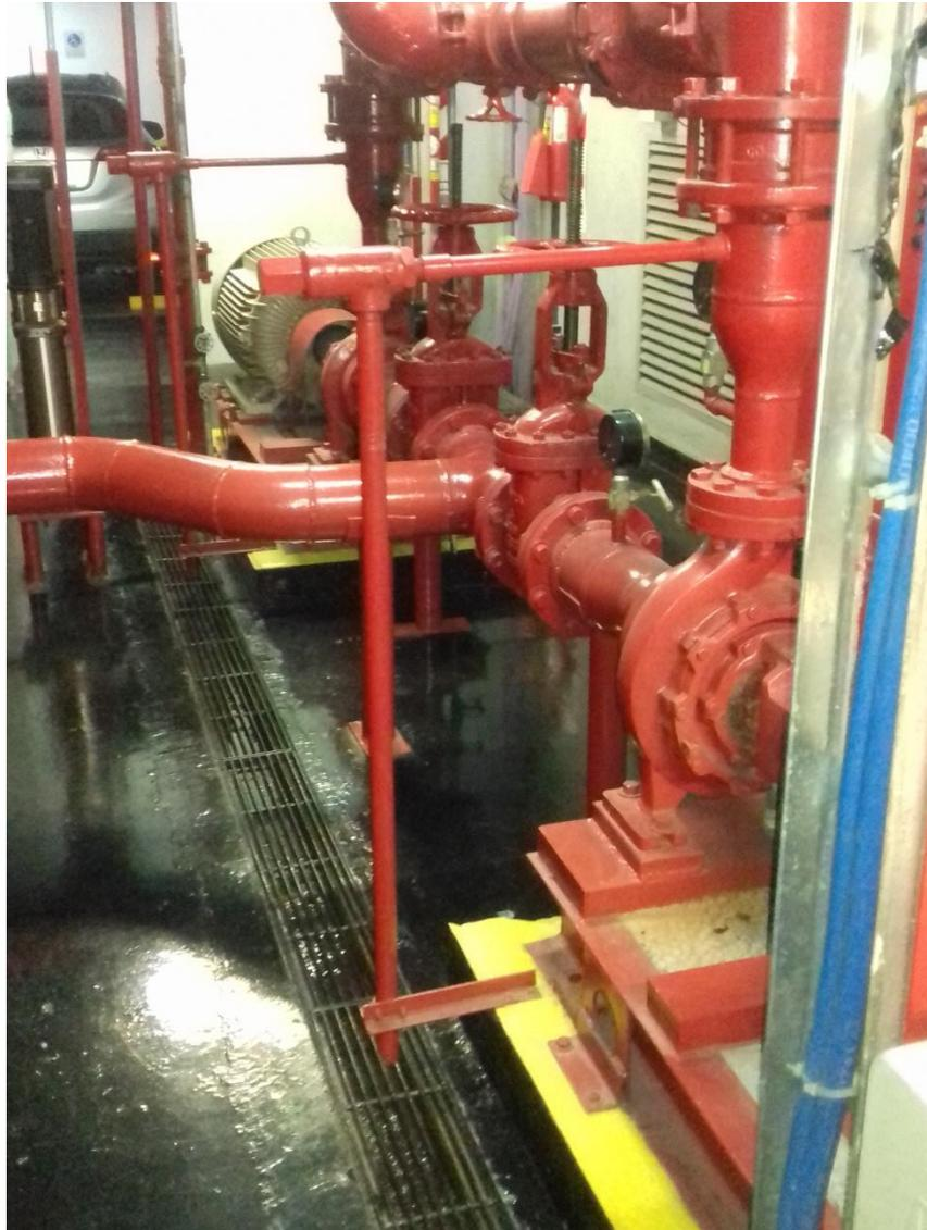
Se observa la válvula de alivio o de recirculación, la cual desemboca en el desagüe.
