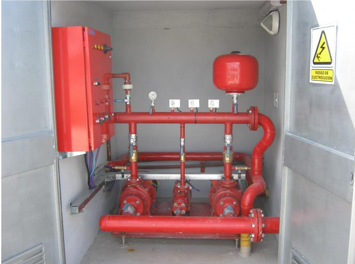
Se observan las válvulas de alivio o de recirculación, las mismas se encuentran en las bombas principal y reserva, en la descarga de las bombas y antes de la válvula de retención. Las mangueras transparentes aún no se encuentran conectadas al desagüe.
