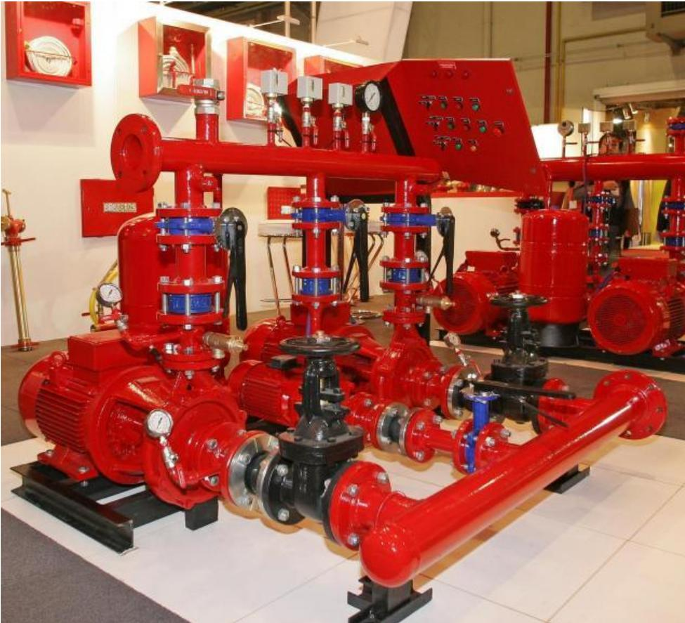
Equipo de presurización, con electrobombas. Las válvulas de alivio o recirculación se observan a la salida de las bombas antes de las válvulas de retención. Las mismas se conectan mediante mangueras transparentes a desagües.
