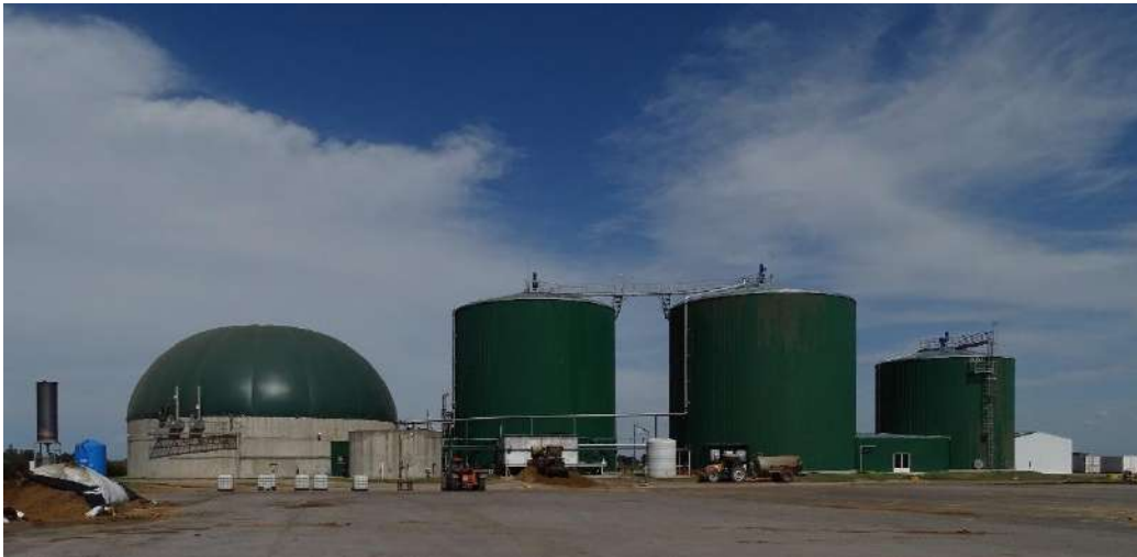
Figura 30 - Planta de biogás con silo de maíz y residuos sólidos agropecuarios. Fuente: Elaboración Propia.
