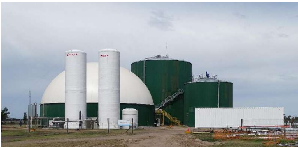
Figura 31 -Planta de biogás con silo de maíz y residuos líquidos de la producción de biocombustibles. Fuente: Elaboración Propia.
