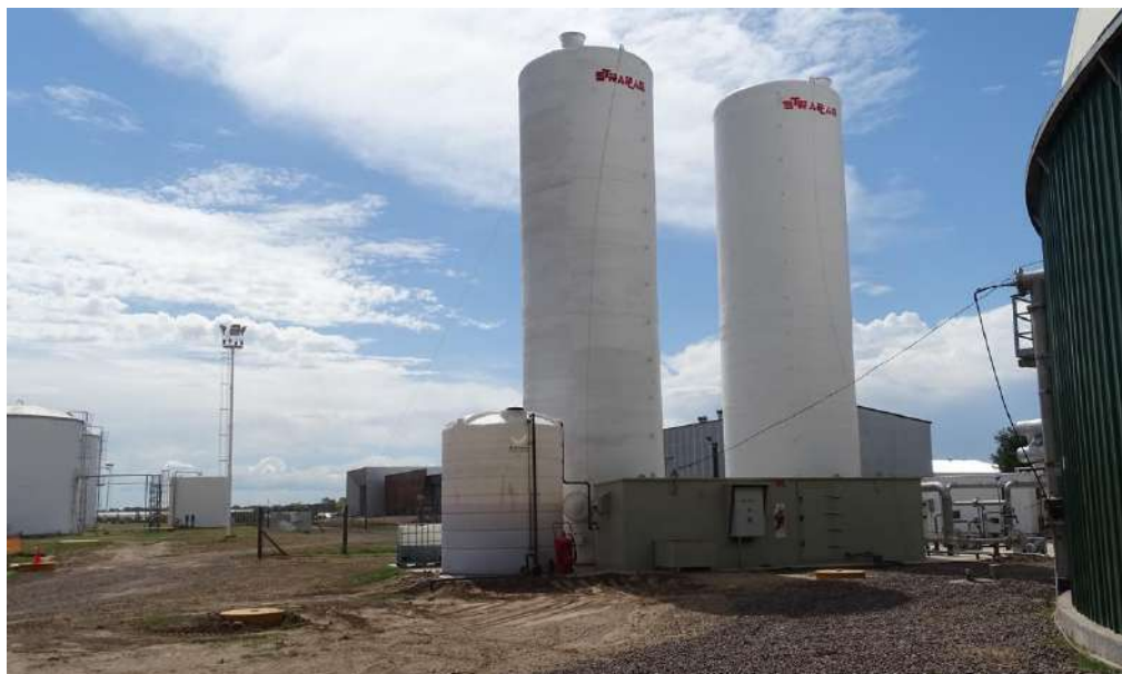
Figura 22 - Sistema de desulfuración de 2 torres en una planta de biogás. Fuente: Elaboración Propia
