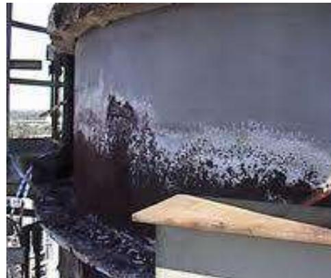
6) El tratamiento apropiado (recubrimiento) de la superficie exterior del cuerpo del recipiente, y el mantenimiento de la resistencia a la intemperie de la parte exterior de la aislación, son las claves para prevención de daños por CUI.
